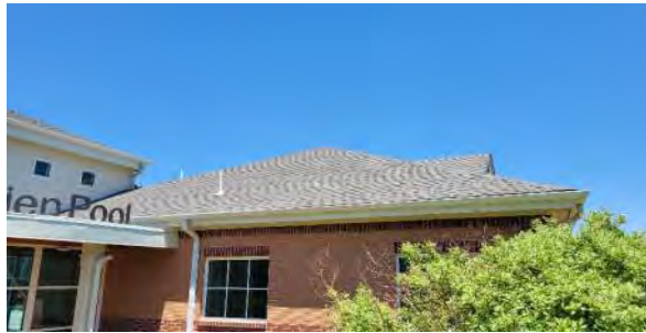
D1.1 Asphalt Roofing
