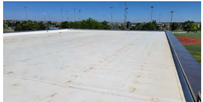
D1.4 Membrane Roof
