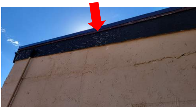
D4.1 Fascia, Window & Door Frames
