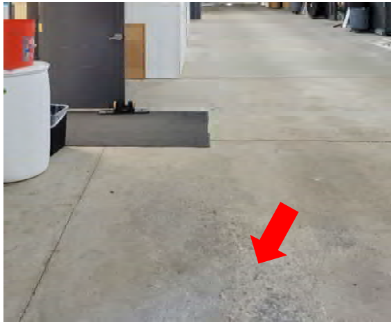
E1.3 Concrete Floor
