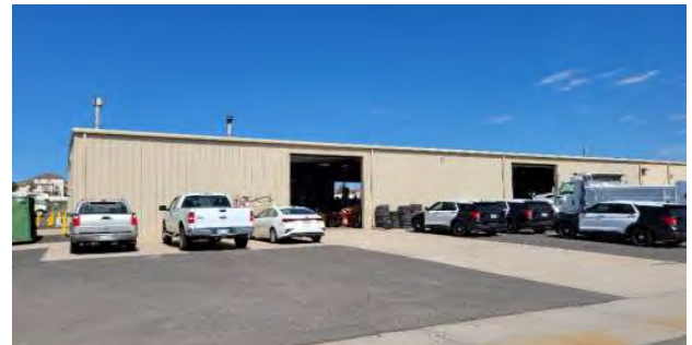
D2.2 Overhead Doors
